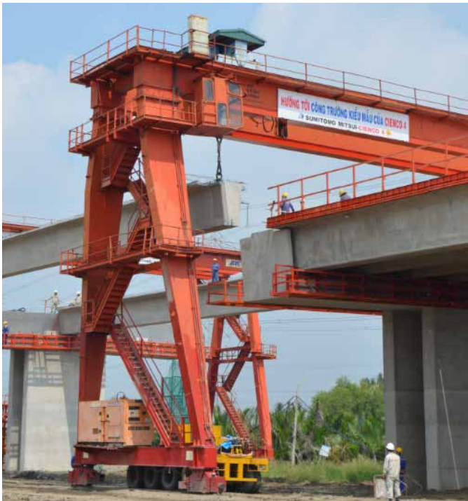
Đúc và lắp đặt Super T cầu Tào, Tỉnh Thanh Hóa
