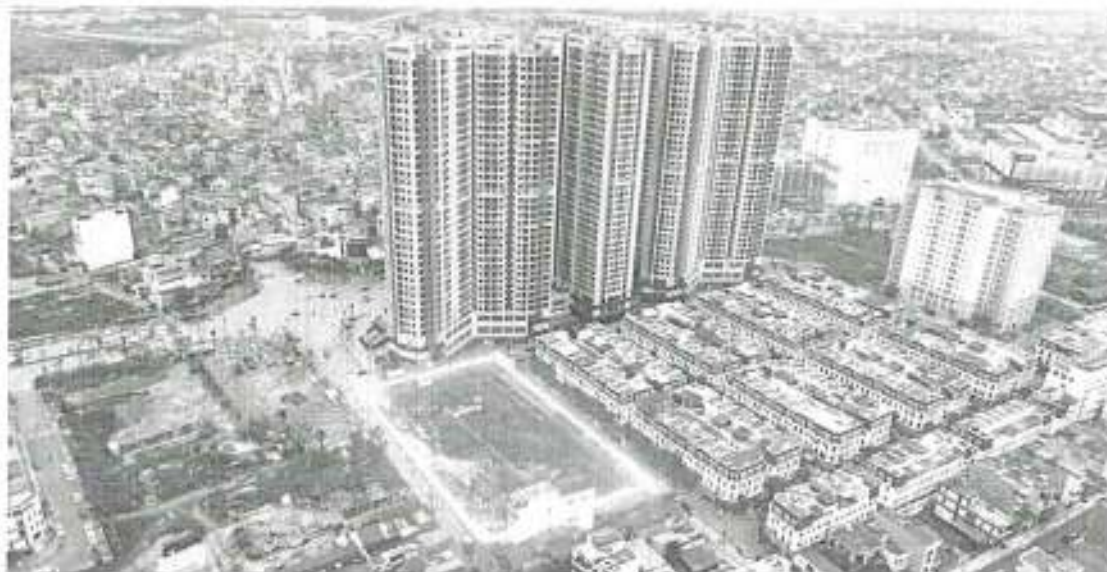
Vị trí tòa H2 đang triển khai thi công bên cạnh Tòa H1 của dự án Hoàng Huy Commerr và dự án Hoàng Huy Mall Công ty đã hoàn thành đầu tư
