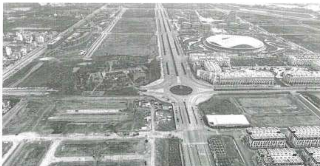
Một góc dự án đang thi công nhìn về khu Trung tâm hành chính mới của Thành phố Hải Phòng tháng 4 năm 2025.
