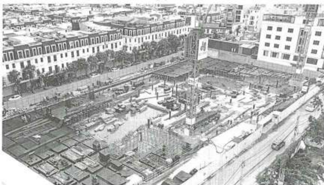
Cận cảnh Tòa H2 đang được thi công trong tháng 4/2025
