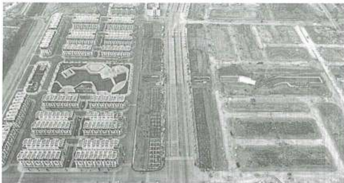
Dự án đang triển khai san lấp mặt bằng và triển khai thi công hạ tầng nội khu, xây dựng một số khu nhà ở liền kề
