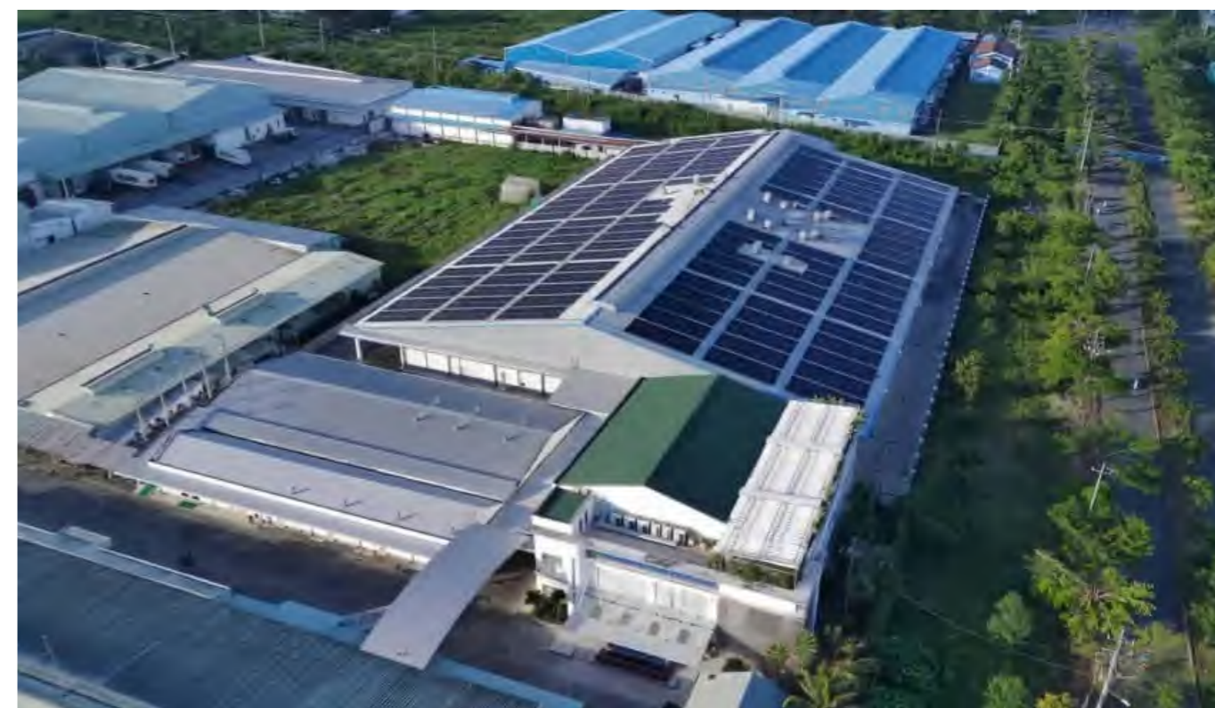
Hệ thống năng lượng mặt trời mái nhà tại Khang An Foods
