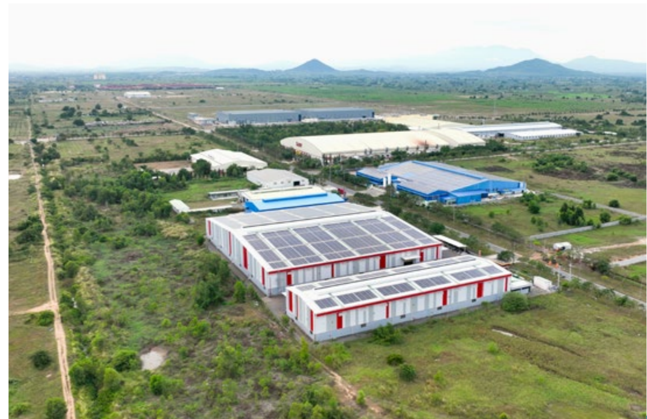
KHU CÔNG NGHIỆP HÀM KIỆM 1
