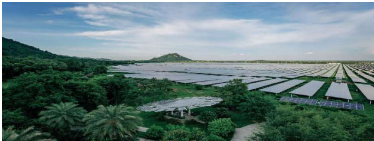
Điện mặt trời An Hảo
