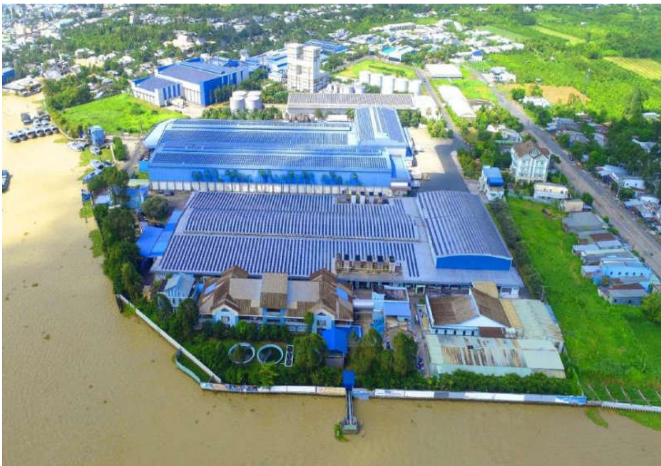
Cụm công nghiệp Vàm Cống và các nhà máy của IDI
