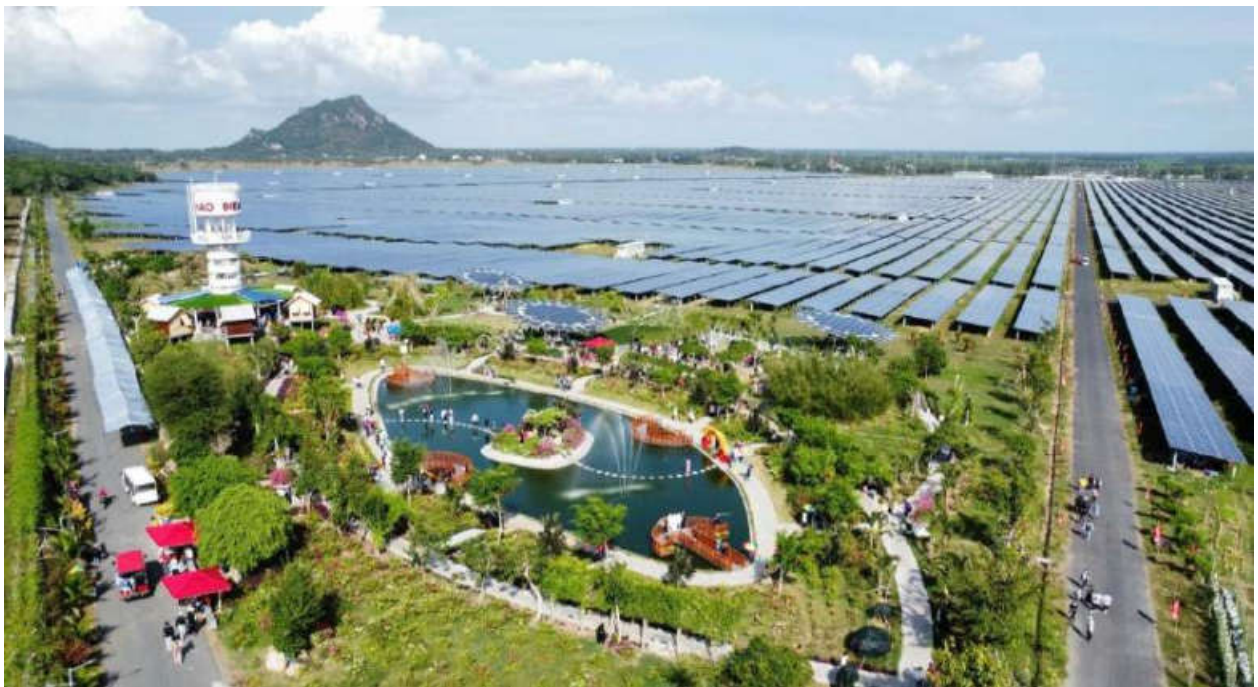
Toàn cảnh dự án Khu du lịch điện mặt trời An Hào
