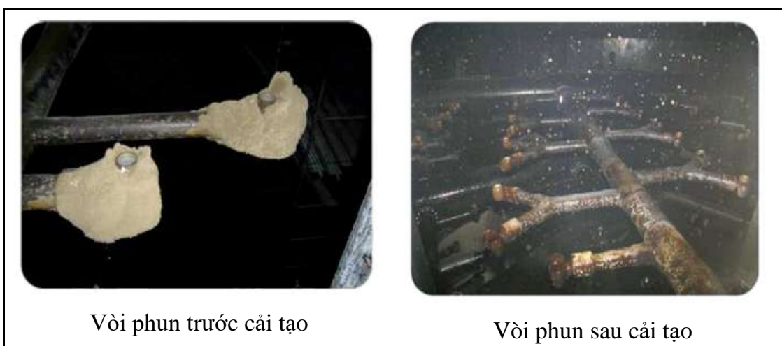
Hình 2.3.12: Cải tạo vòi phun tại nhà máy điện Iskenderu
