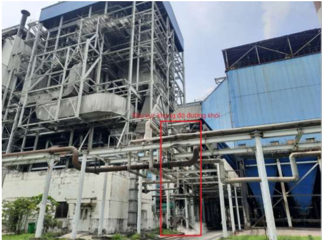
Hình 5.3: Hình ảnh hiện trạng khu vực khung đỡ đường khói
