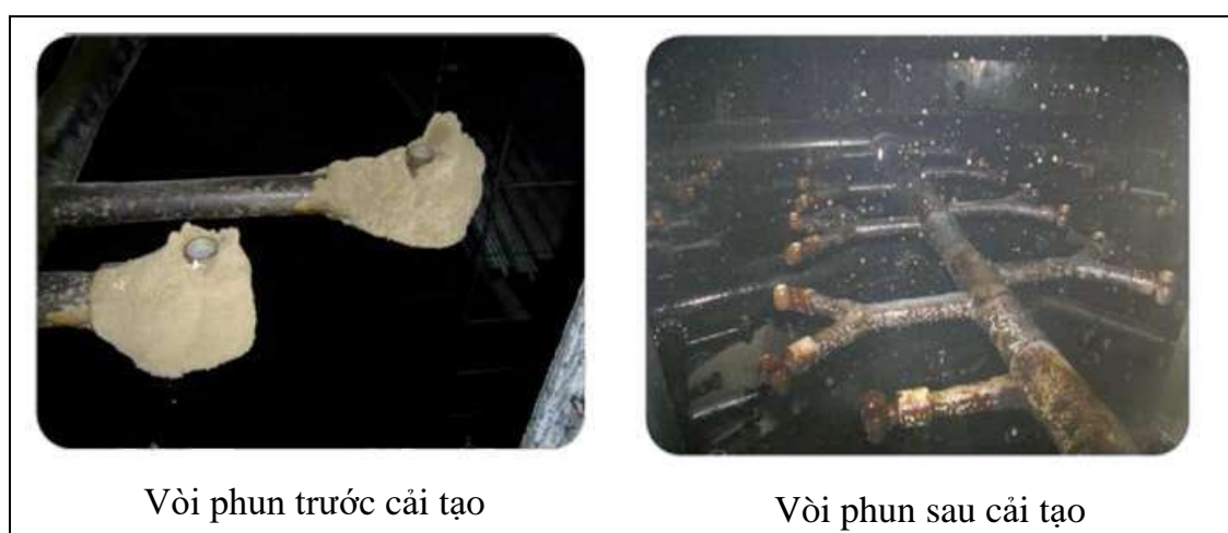
Hình 4.3.17: Cải tạo vòi phun tại nhà máy điện Iskenderu
