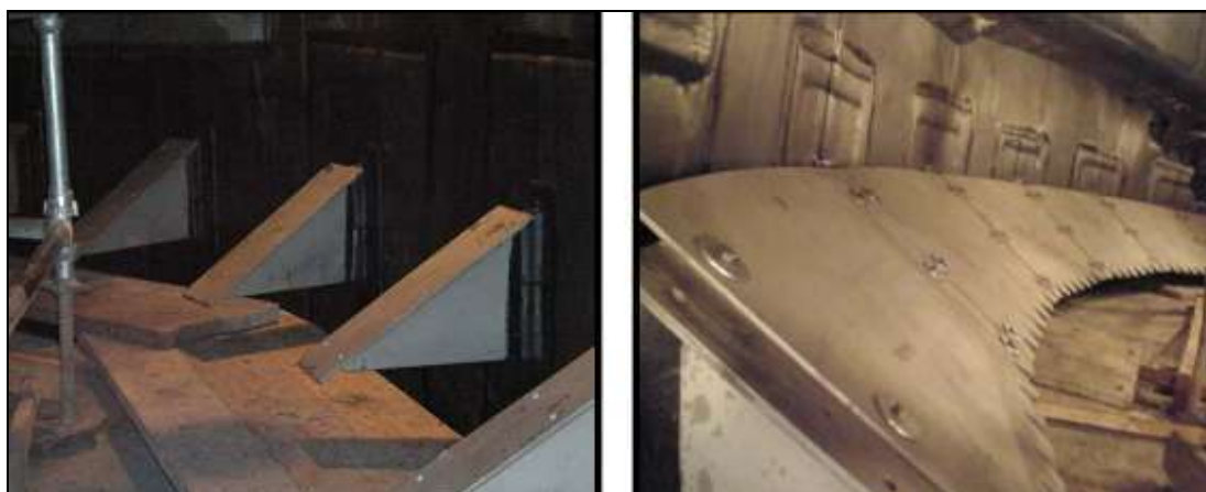
Hình 4.3.11: Lắp đặt các vành chắn tại tổ máy 2 nhà máy BL England
