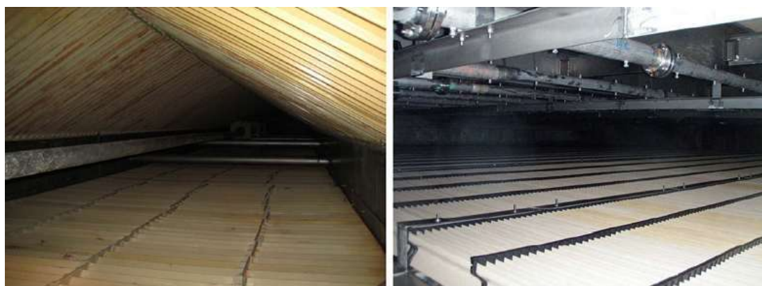
Hình 4.2.18: Nâng cấp vòi phun và khay phân phối khói tại nhà máy điện Fayette
