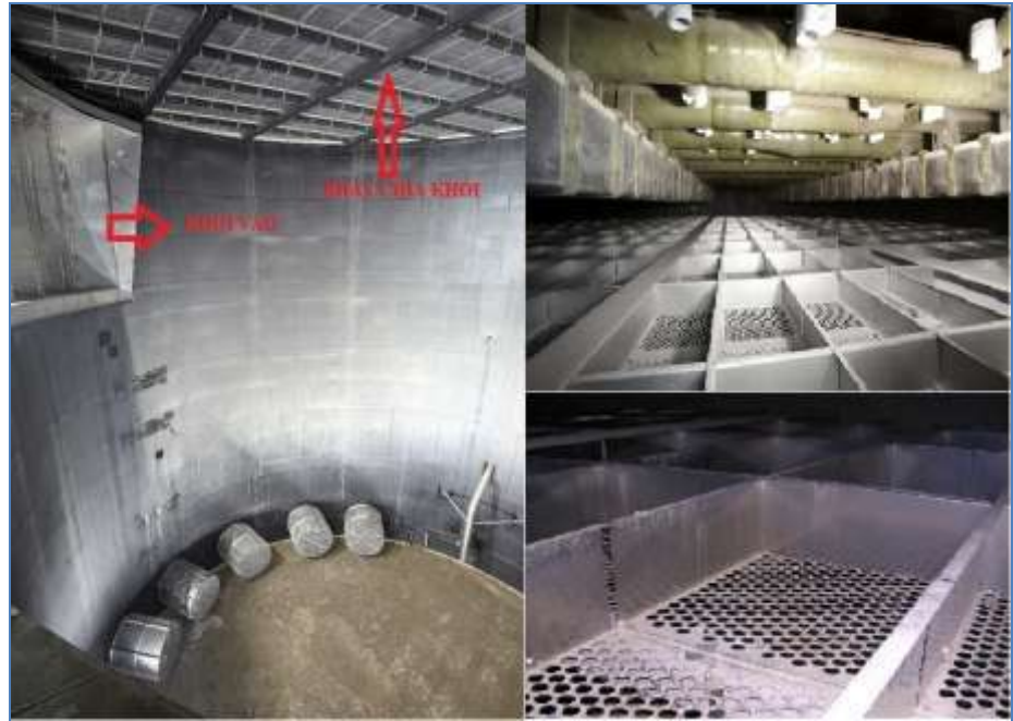
Hình 4.3.14: Vị trí và hình dạng khay chia khối lắp mới
