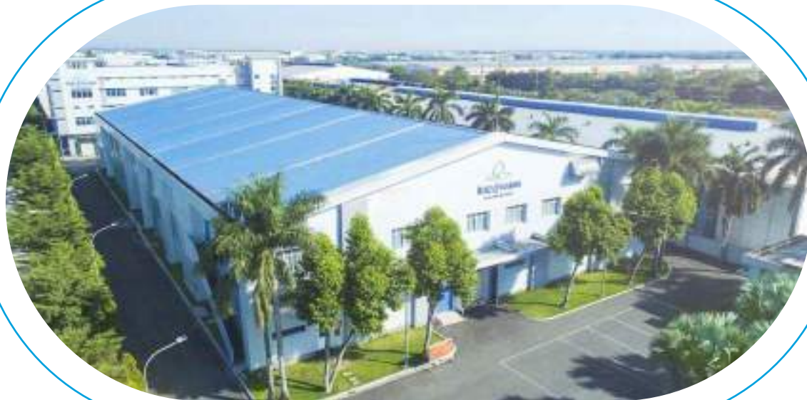
Nhà máy IMP 3
