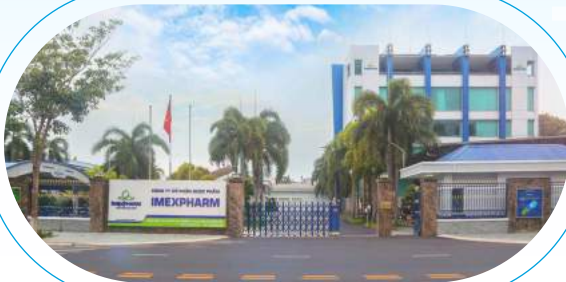
Nhà máy IMP 1
