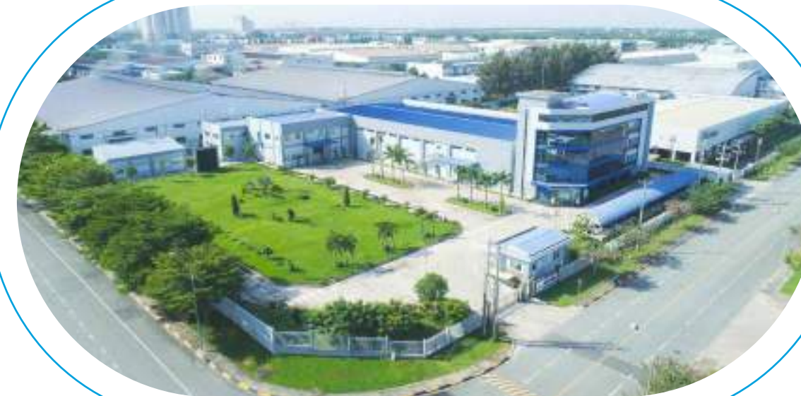
Nhà máy IMP 4
