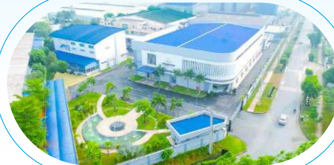
Nhà máy IMP 2
