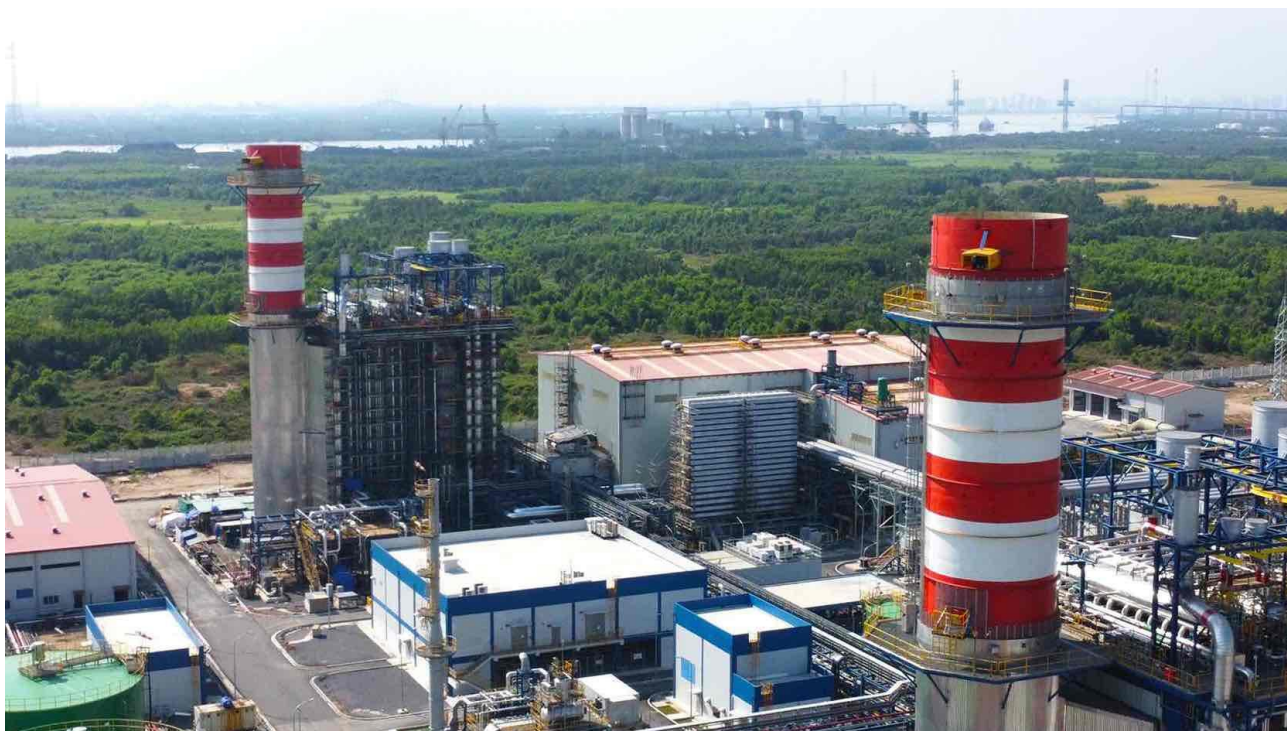
Nhà máy điện Nhơn Trạch 3&4, tháng 3/2025. Nguồn: Báo Lao động
