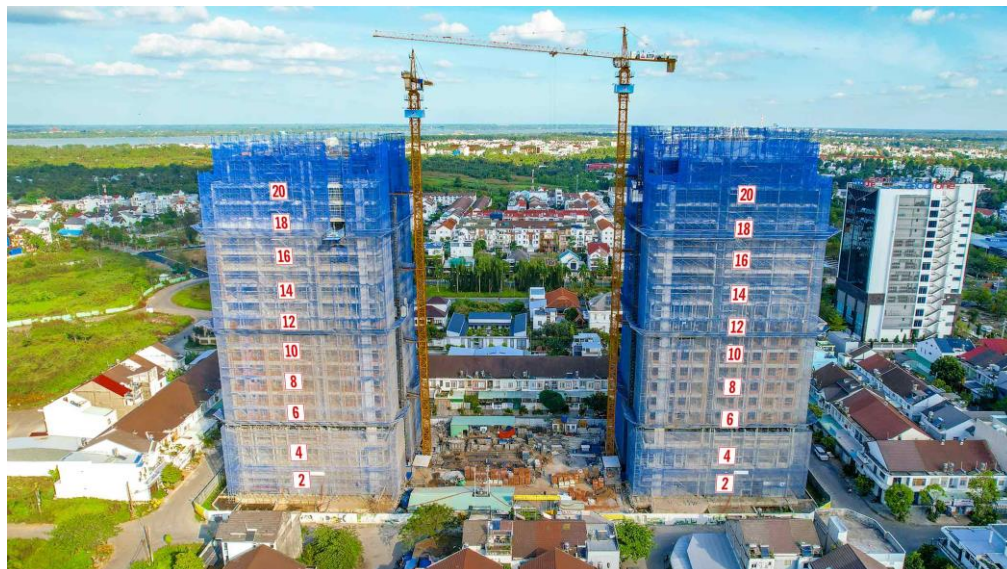
Hình 2: Cara River Park – đã cất nóc 2 tòa vào 05/03/2025
