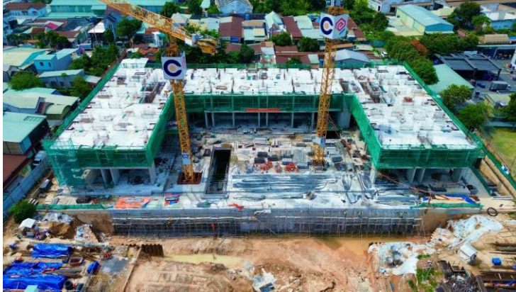
Hình 1: Tiến độ xây dựng tại Thuận An 1
