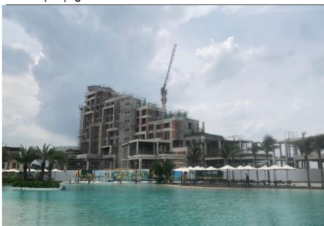
Hình 19: Khách sạn MGallery tại The Tropicana đang cất nóc, dự kiến hoạt động từ 2023
