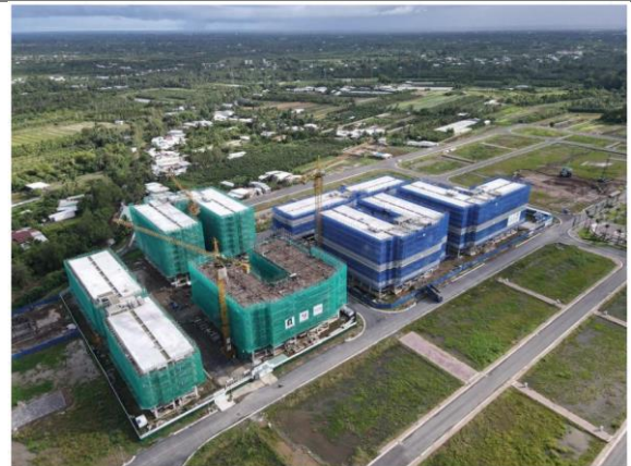
Tiến độ xây dựng EhomeS Cần Thơ (Central Lake)
